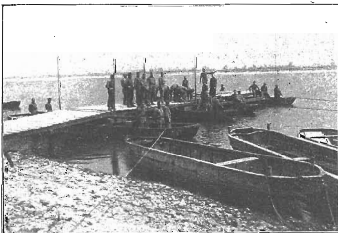
Budowa mostu pontonowego (rok 1920).
