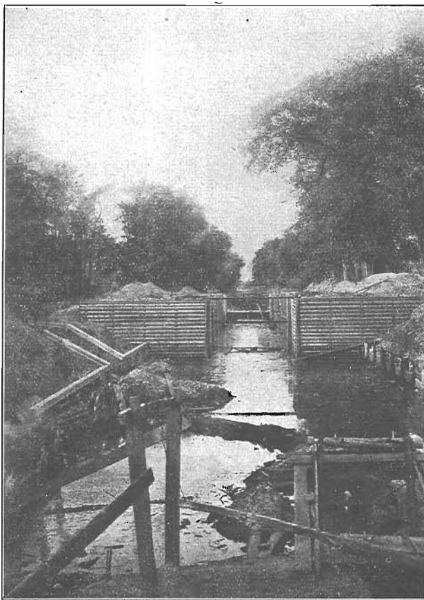
Kanał Ogińskiego.—Budowa szluzu w Telechanach.
