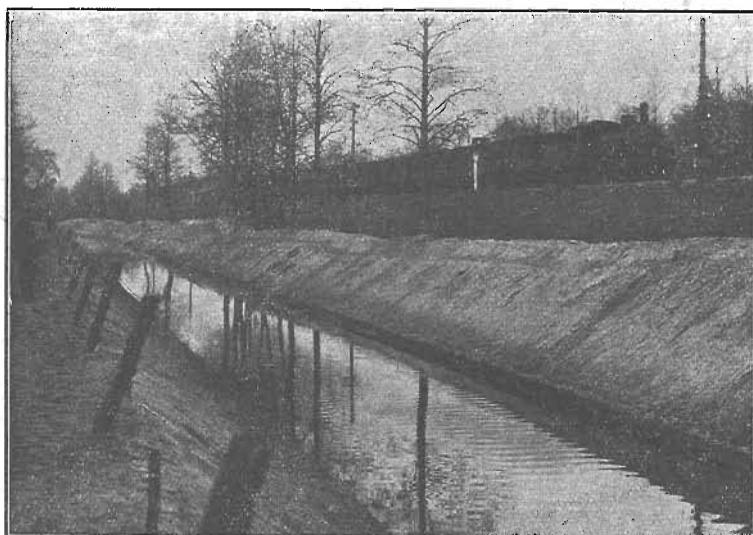
Widok kanału po ukończeniu robót.
