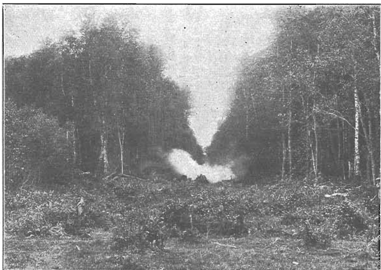
Karczowanie pni drzewnych na trasie kanału materjałem wybuchowym.
