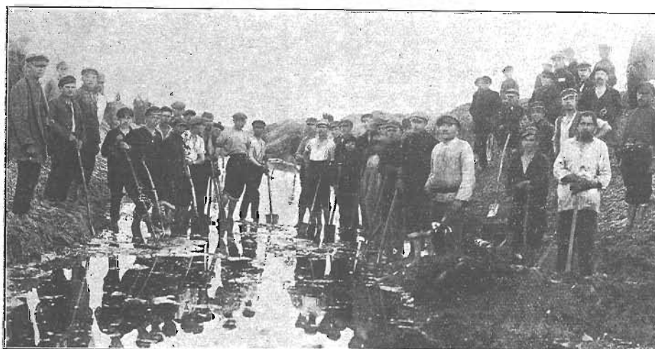
Grupa robotników na odcinku kanału podczas pracy.
