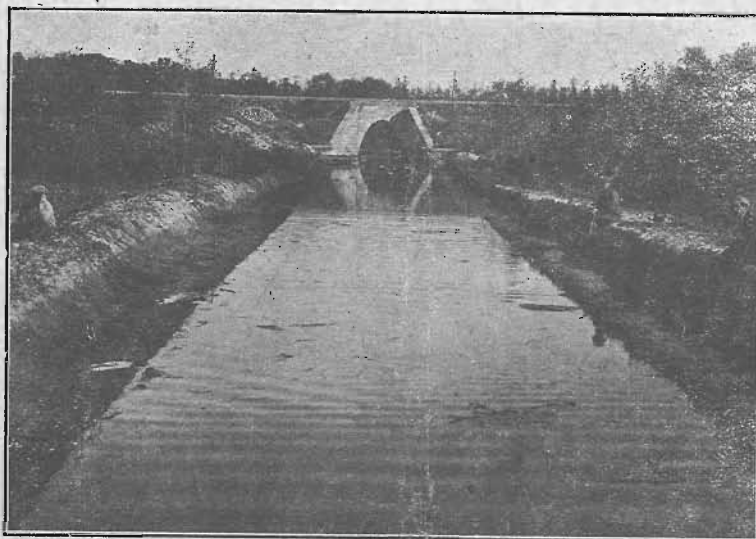
ODBUDOWA KANAŁU IM. GEN. I. ŻYLIŃSKIEGO W POWIECIE ŁUNINECKIM.
