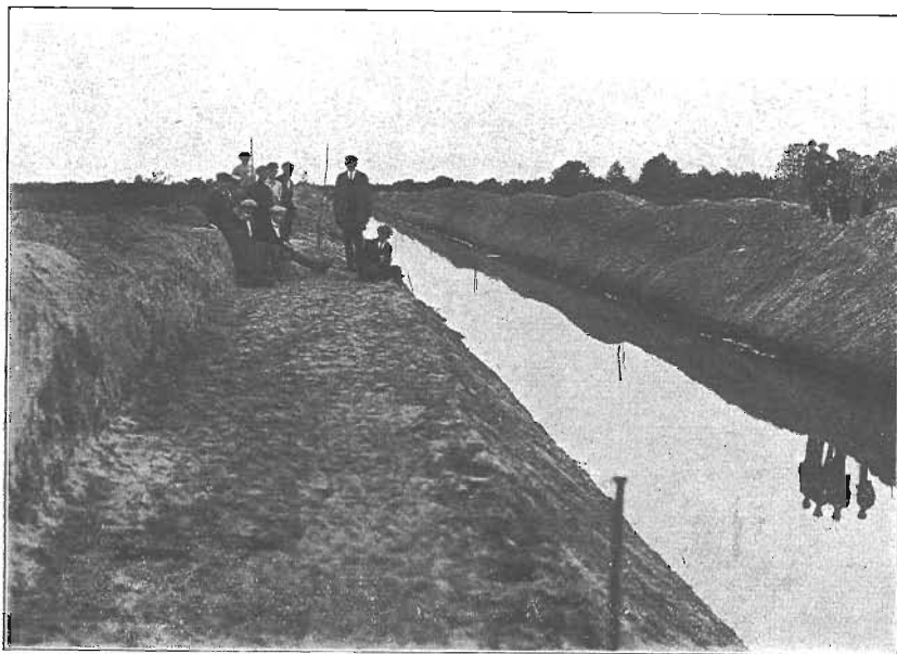
Odcinek kanału przed ukończeniem robót.
