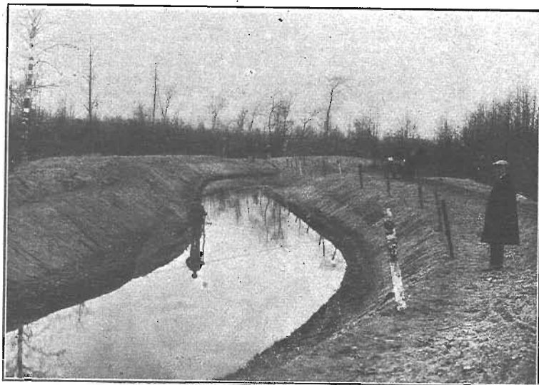
Fragment kanału po ukończeniu robót.
