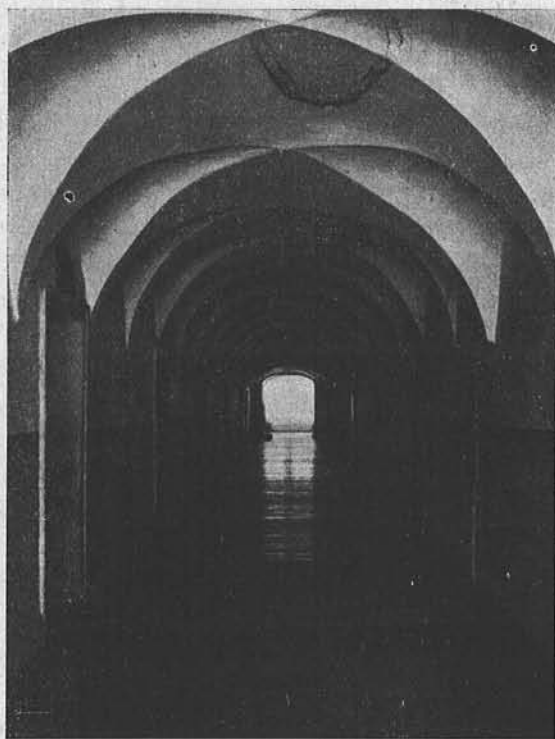
Korytarz I piętra dawnego kolegium jezuickiego (dziś II państw. gimn.)
