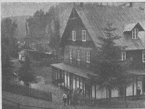
Schronisko w Ojcowie
