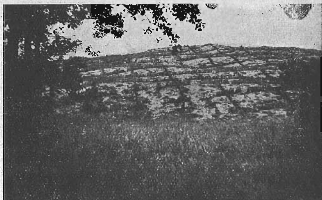
Utrwalanie wydmy przez założenie czworoboków z chrustu i zasadzenie młodych roślinek.
